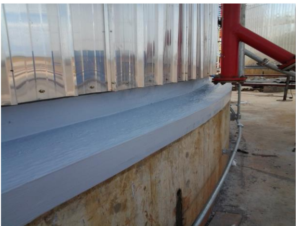
鄯善罐区储罐边缘板GTPU防水材料
