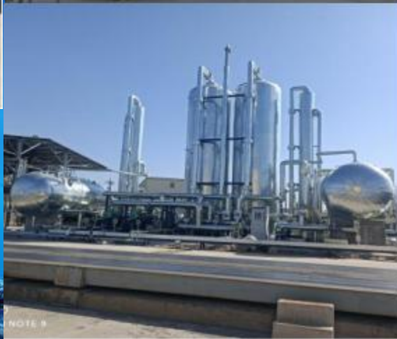
•中石油某石化1200m 3 /h沥青船燃装车
