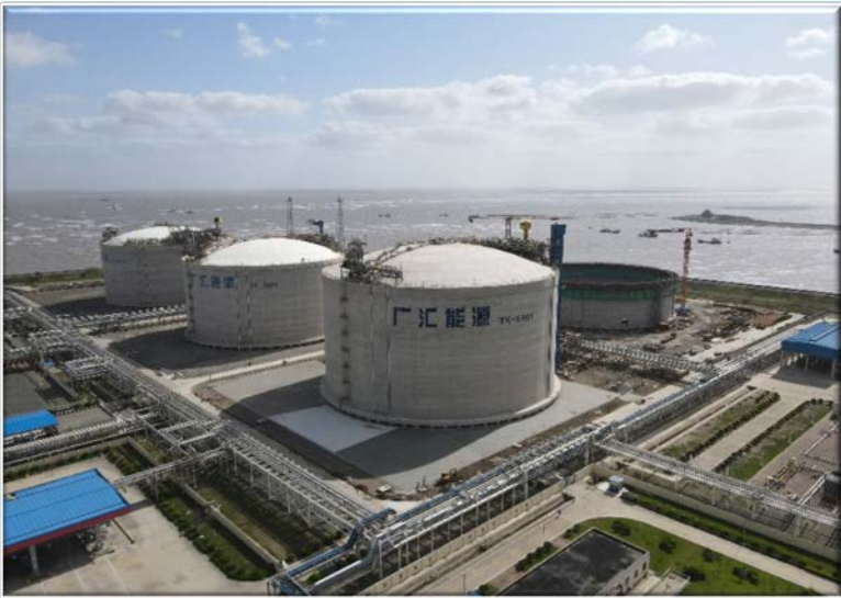
广汇能源LNG分销转运站 5#20万方LNG储罐扩建工程
